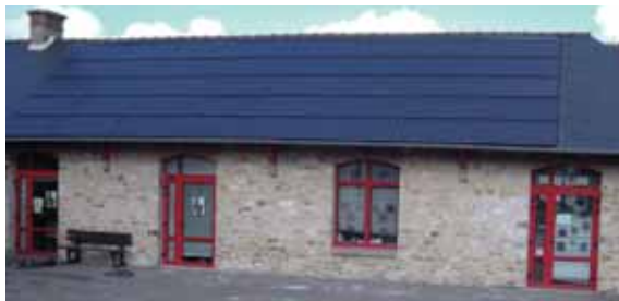
Installation photovoltaïque sur école et salle polyvalente
