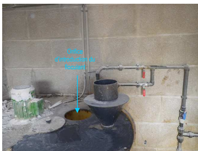
Bac de création de la pulpe à flocculant à ajouter aux eaux chaulées
