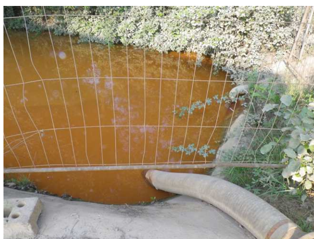
Bassin bétonné de stockage temporaire des boues (avec flexible à droite pour le pompage hebdomadaire)
