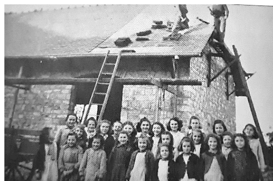
Réparation du toit de l'école publique des filles
